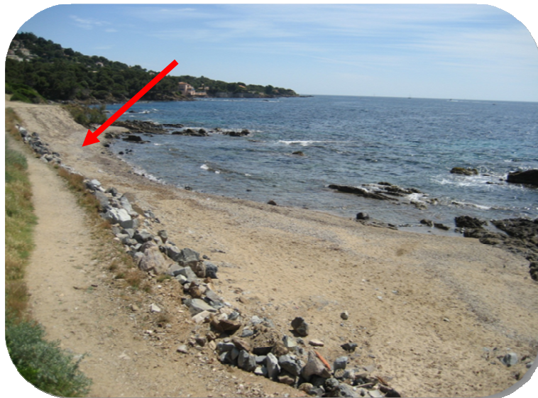
Figure 22 - Création d'un accès à la plage : plage des Actinies à Roquebrune-sur-Argens
